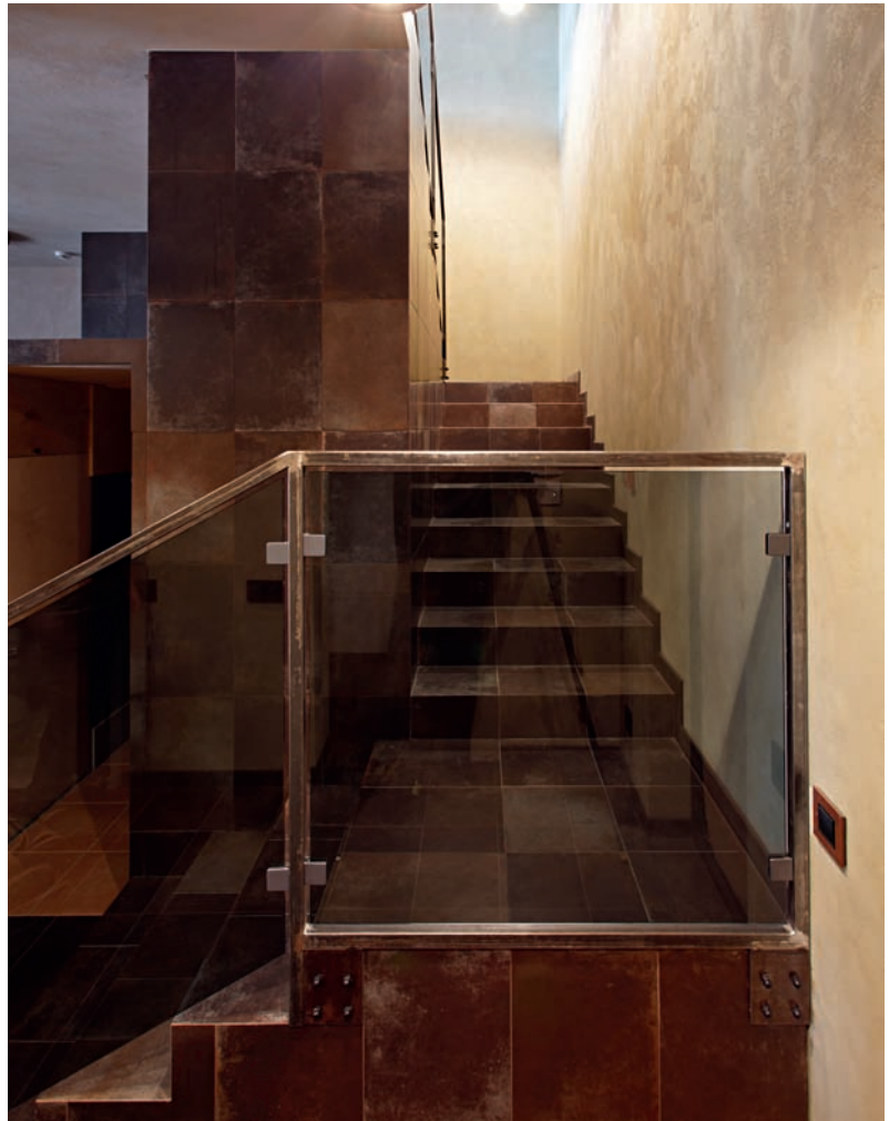
Der Treppenaufgang von der Eingangsebene in den Wohnbereich ist mit rostenden Metallplatten verkleidet. | The staircase from the entrance level to the living area is clad with rusting metal plates.
