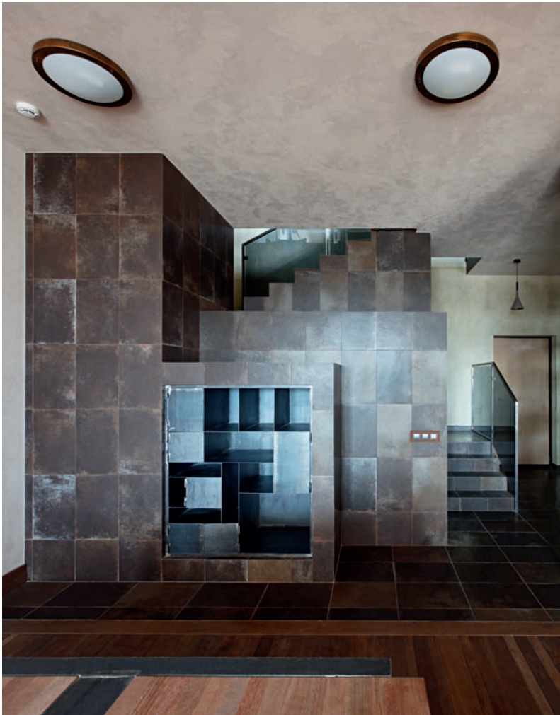
Der Treppenaufgang von der Eingangsebene in den Wohnbereich ist mit rostenden Metallplatten verkleidet. | The staircase from the entrance level to the living area is clad with rusting metal plates.
